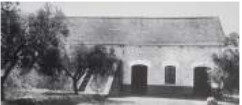
Edificio que albergaba la cámara frigorífica
